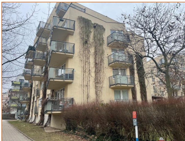
Obrázek číslo 1: Fotodokumentace budovy
